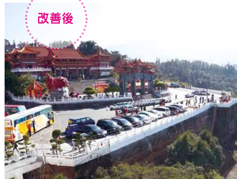
改善後： 攤販拆除後讓遊客有更優質的日月潭觀景空間，提升文武廟整體周邊景觀形象。
