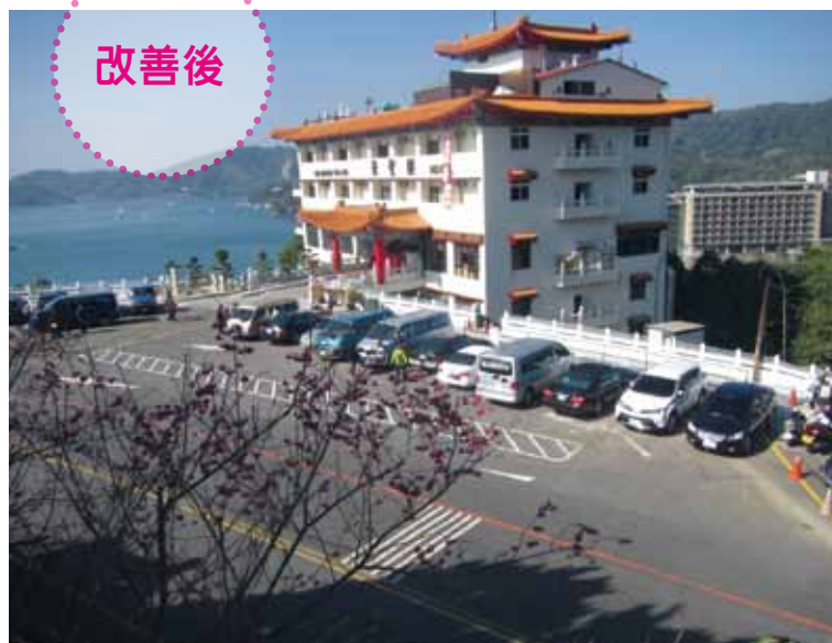
改善後： 鋪面與標線改善措施讓遊客車輛能整齊停放、井然有序，讓再次到訪文武廟的遊客耳目一新。
